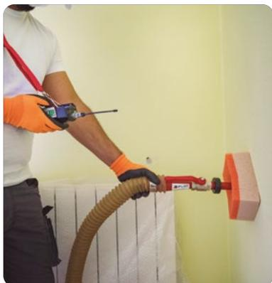
Fase di insufflaggio, posa verticale in strutture a telaio (timber frame)
