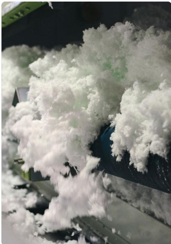
Si tratta di una lana minerale bianca che si applica con la tecnica dell'insufflaggio meccanico, utilizzando macchinari progettati espressamente per tale impiego.
