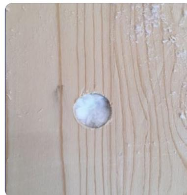
Foro d'ingresso: terminato l'insufflaggio, viene sigillato, per completare l'opera con le finiture
